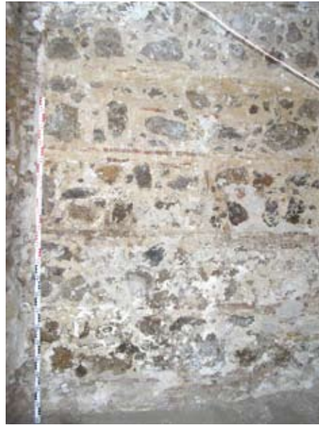
Figura 7. Paramento de mampostería entre dobles verdugadas de ladrillo característico de los siglos XIV-XV.
